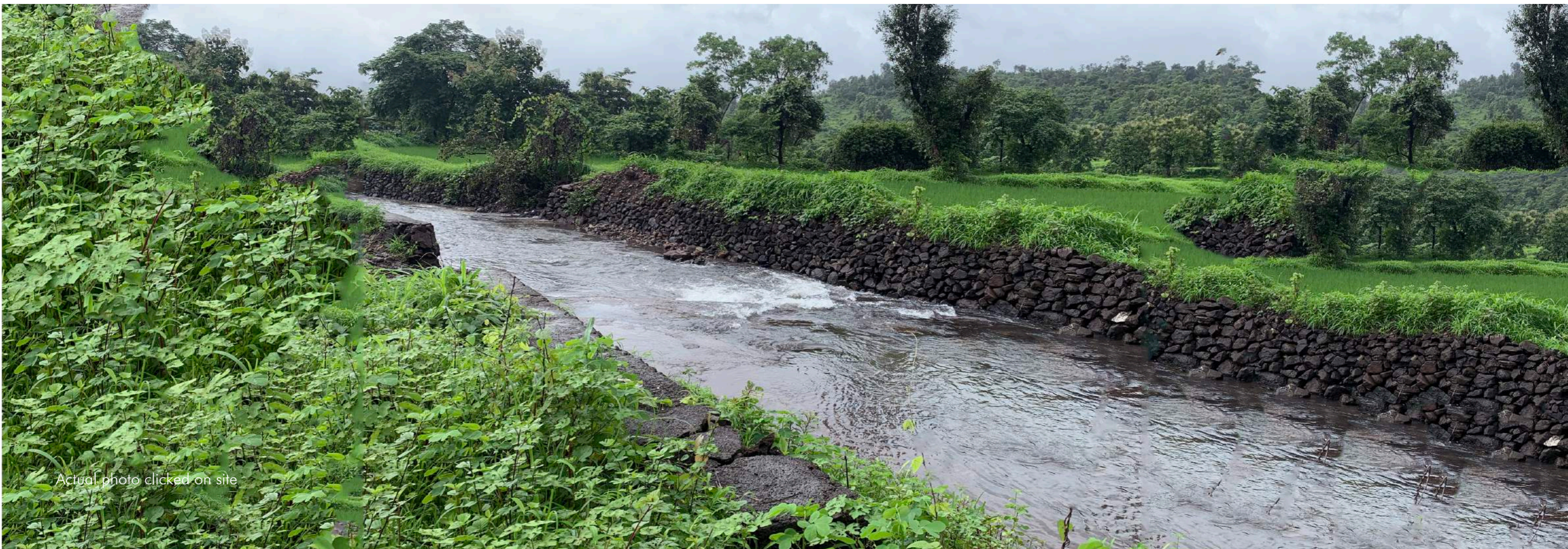
Actual photo clicked on site
