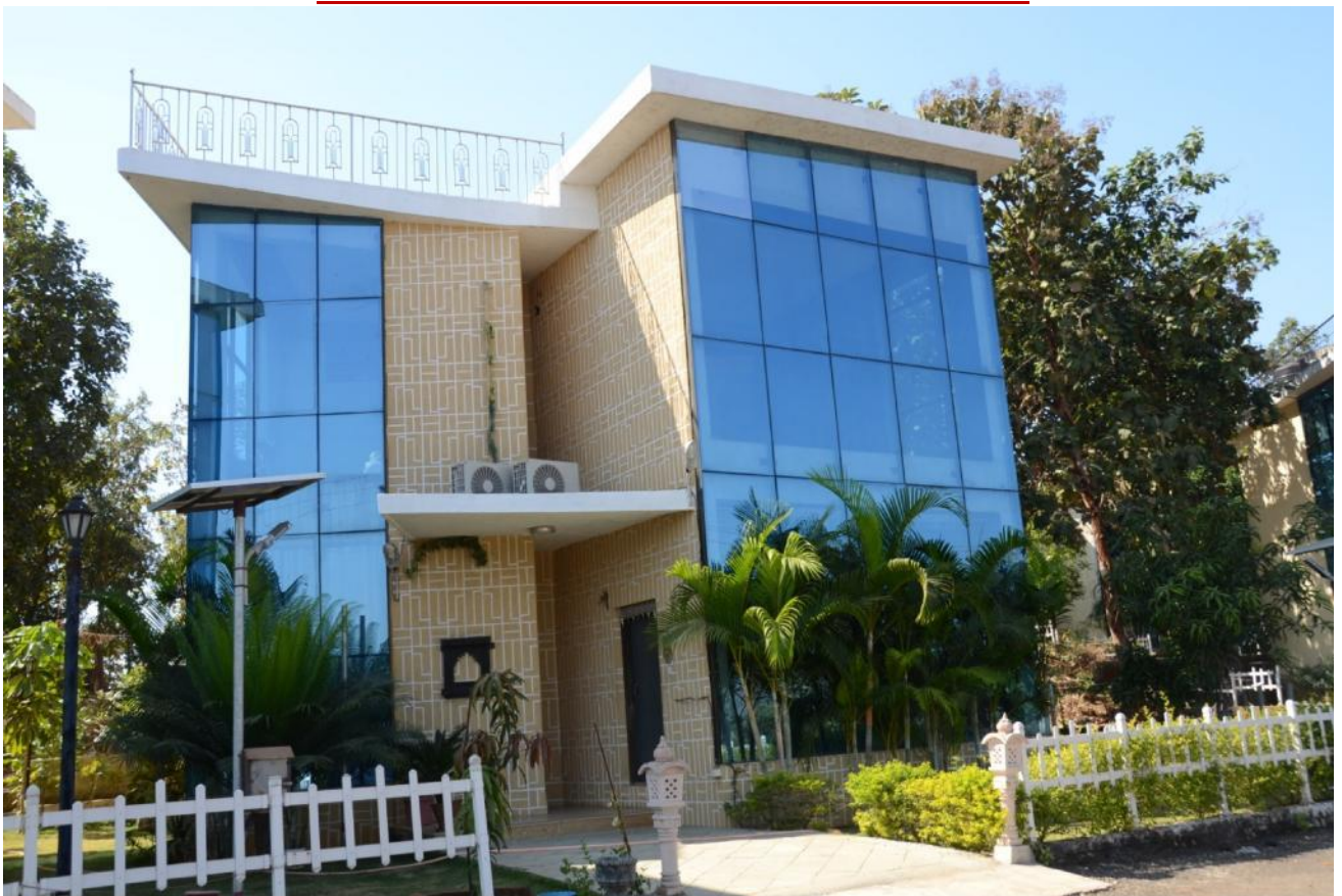
ACTUAL PHOTO OF GLASS VILLA
