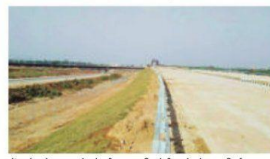
टोक रोड से आगरा रोड के बीच 19.4 किलोमीटर के रोड का निर्माण।
