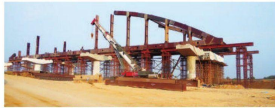
टोक रोड से आगरा रोड के बीच रेलवे ओवर ब्रिज का निर्माण।
