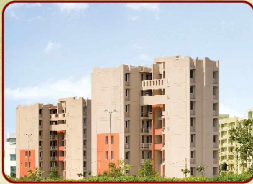
Actual Site Image
